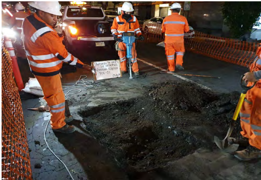
Figura 3. Levantamiento geotécnico y muestreo PCA-01
