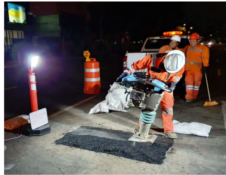
Figura 10. Colocación de asfalto en el PCA-2
