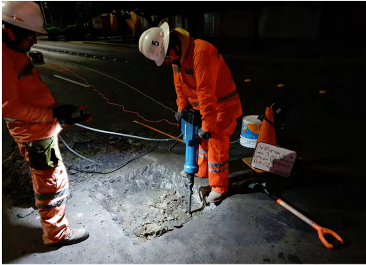
Figura 5. Excavación de PCA-02
