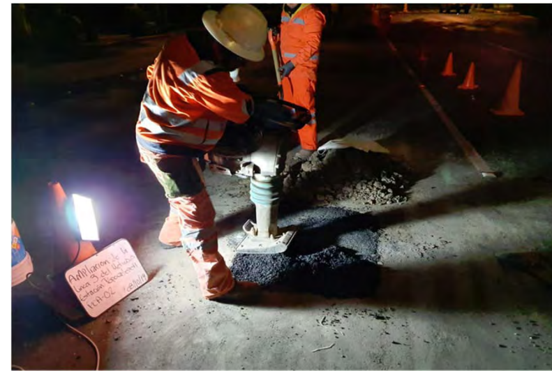
Figura 8. Colocación de asfalto en el PCA-02
