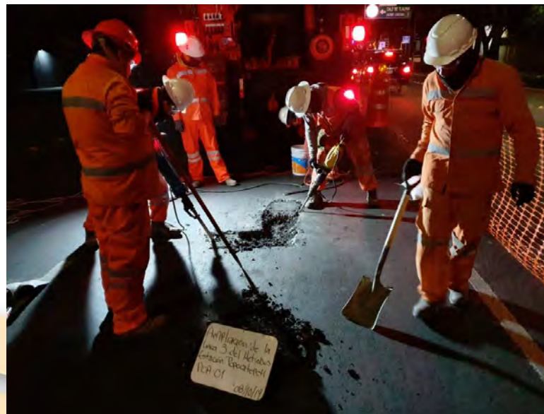
Figura 2.1. Vista de la excavación del PCA-01
