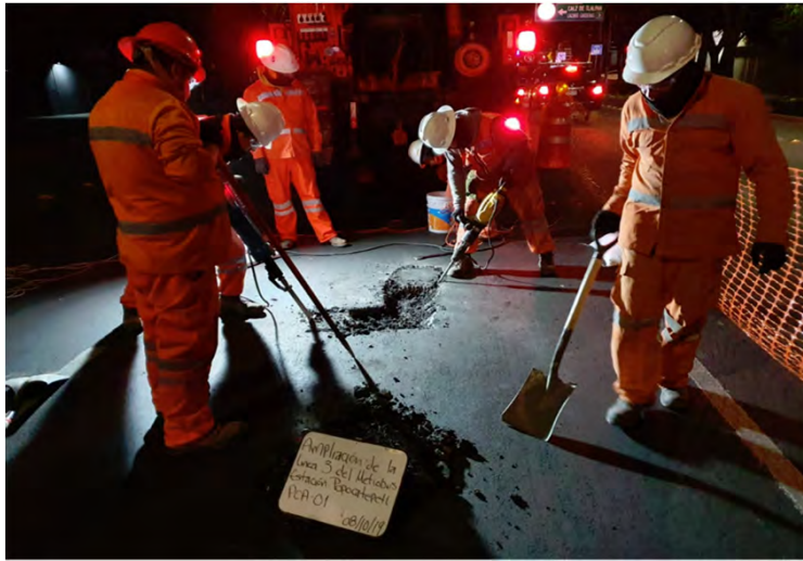
Figura 3. Maniobra de extracción de muestra inalterada PCA-01
