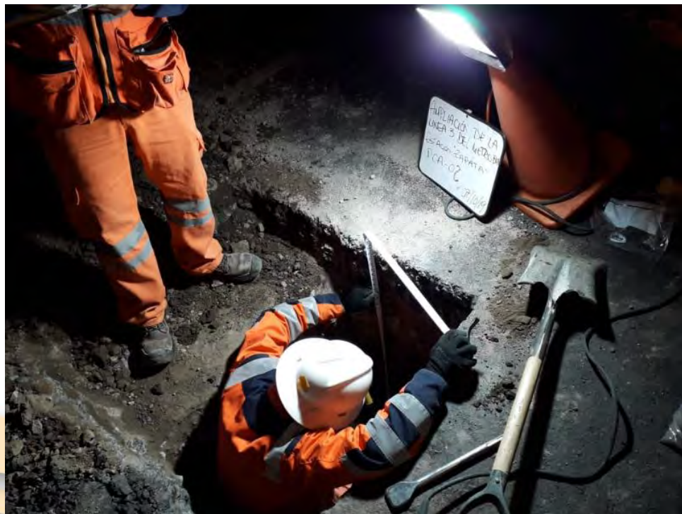
Figura 2.3. Levantamiento geotécnico en el PCA-02
