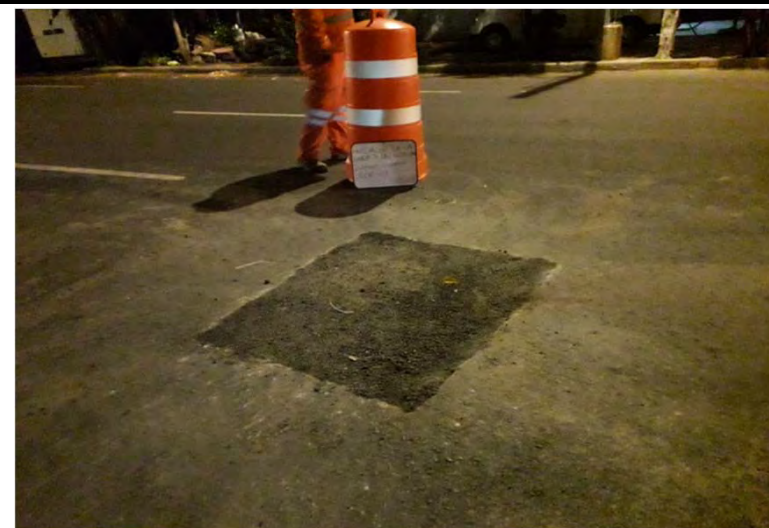
Figura 8. Colocación de asfalto en el PCA-01
