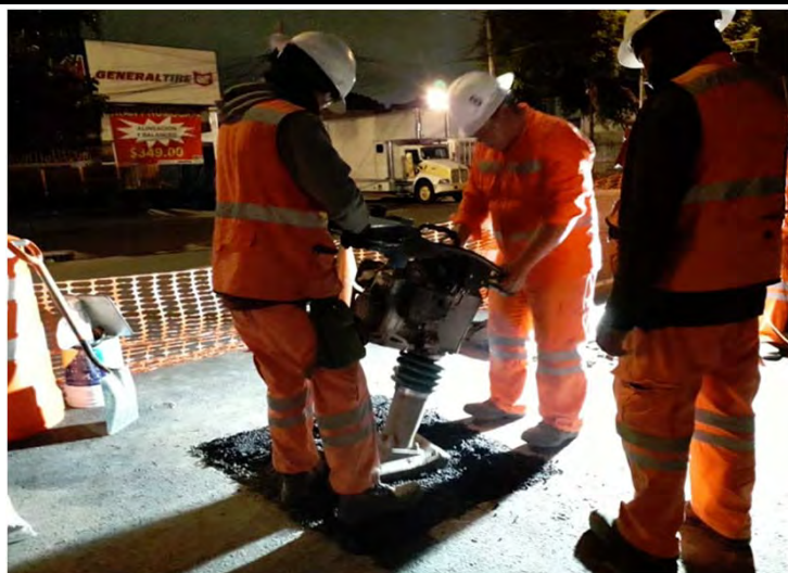
Figura 7. Colocación de asfalto en el PCA-01
