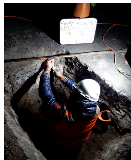
Figura 4. Levantamiento geotécnico y muestreo PCA-01
