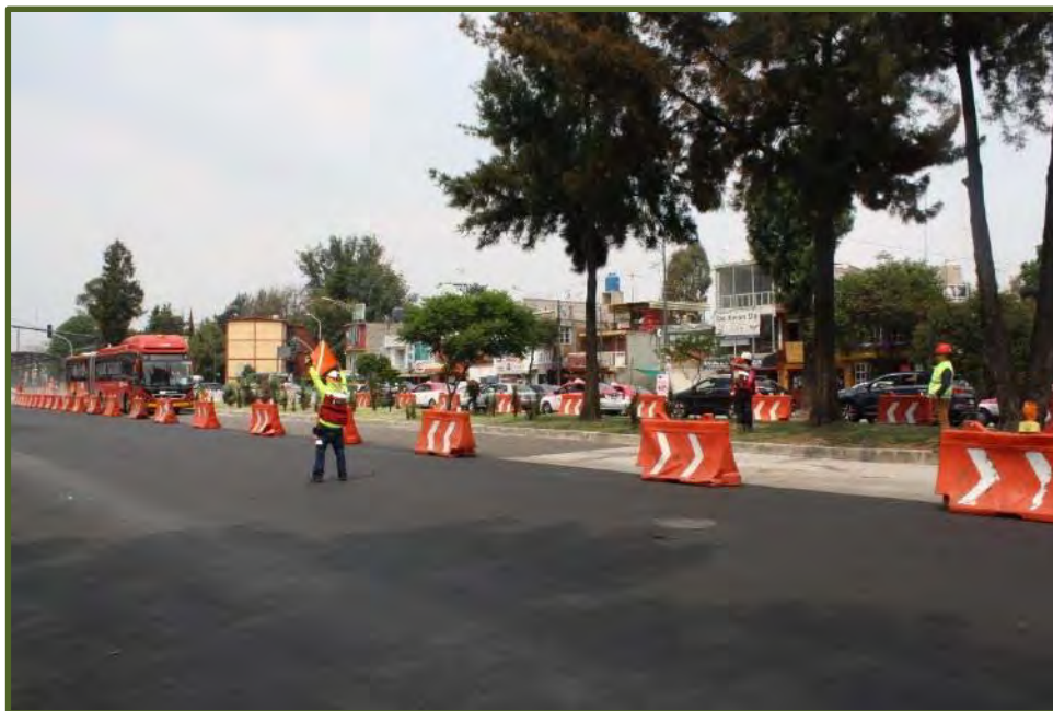
Fotografía No. 16.- Imagen de personal de apoyo en los trabajos de campo.
