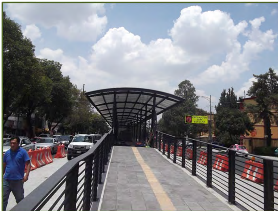
Fotografía No. 1.- Imagen de la Estación Manuela Sáenz, con vista hacia el norte, desde la calle Manuela Sáenz.
