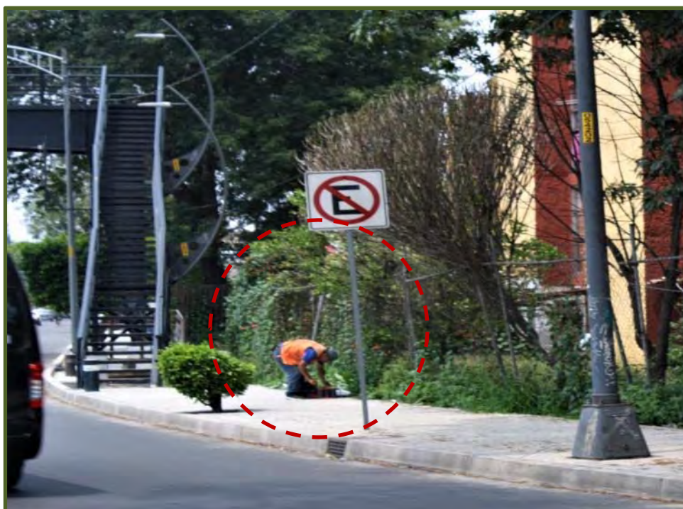
Fotografía No. 15.- Imagen de colocación del equipo de medición, en zona de puente peatonal. En esta estación solo se colocó un equipo de medición.
