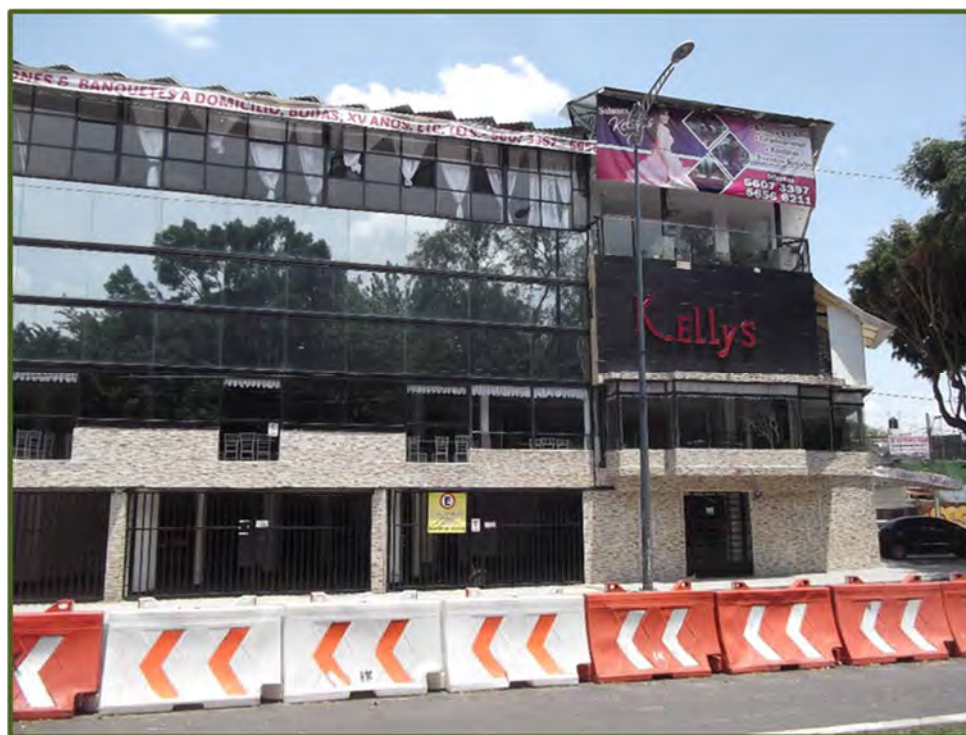
Fotografía No. 11.- Punto de interés 8 para estudio, salón de fiestas Kellys, con vista hacia el oriente, desde la vialidad oriente de la Av. Carlota Armero (Eje 3 Oriente).
