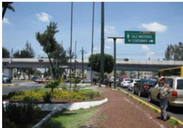
Punto 18. Martín Carrera. Se observan líneas blancas sobre el camellón, aparentemente marcando el lugar de las obras para la estación.
