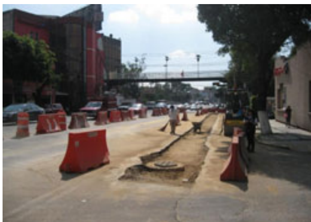
Punto 23. Deportivo 18 de Marzo. Obras aparentemente realizadas por SACMEX.
