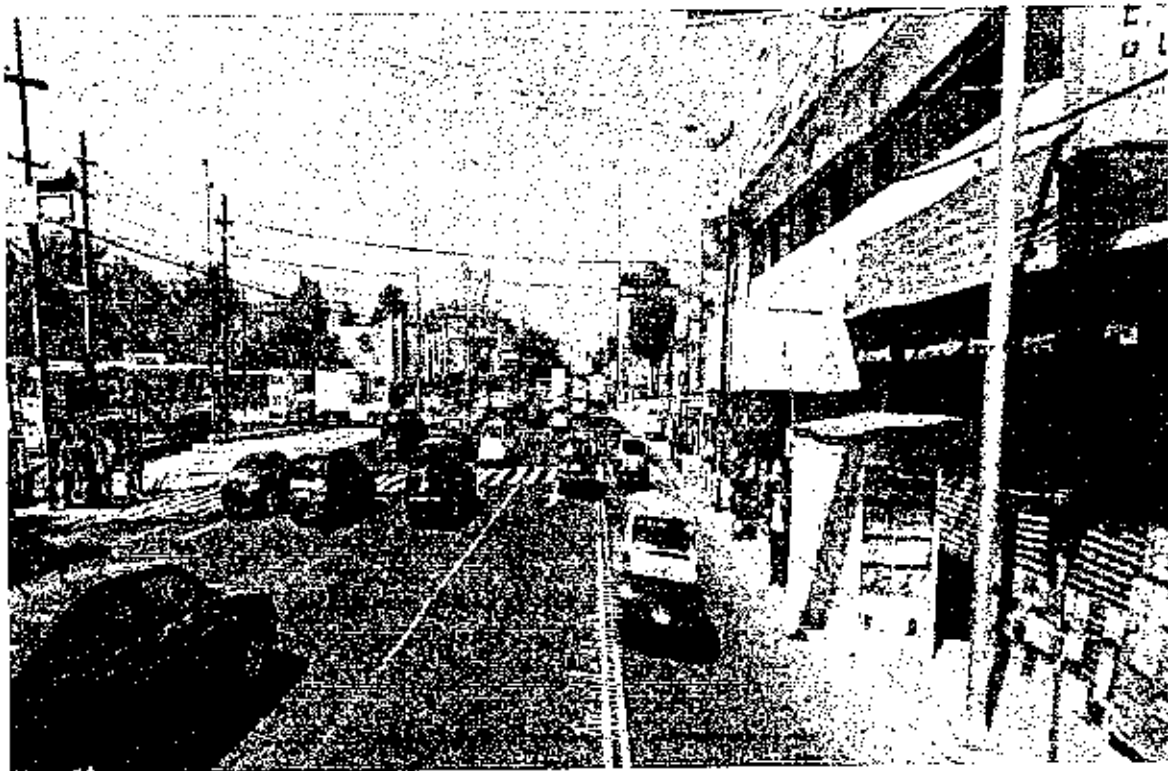
MIA General "Construcción del Corredor Vial para el Transporte Público Línea 6 Metrobús en el Eje 5 Norte de la Avenida Hank González hacia el Metro Rosario con una Influencia en las Delegaciones Gustavo A. Madero y Azcapotzalco"
