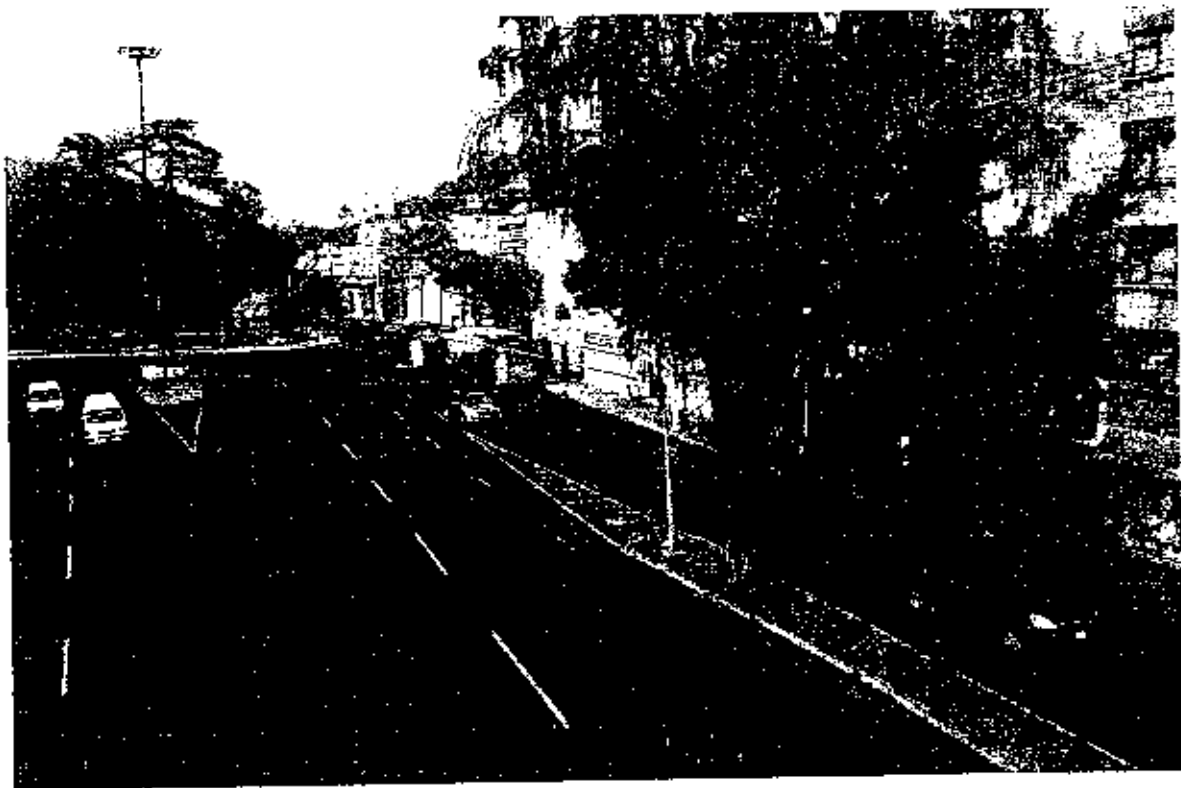
Figura 25. Inicio de Calz. de los Misterios con Av. Cantera, Del. Gustavo A. Madero.
