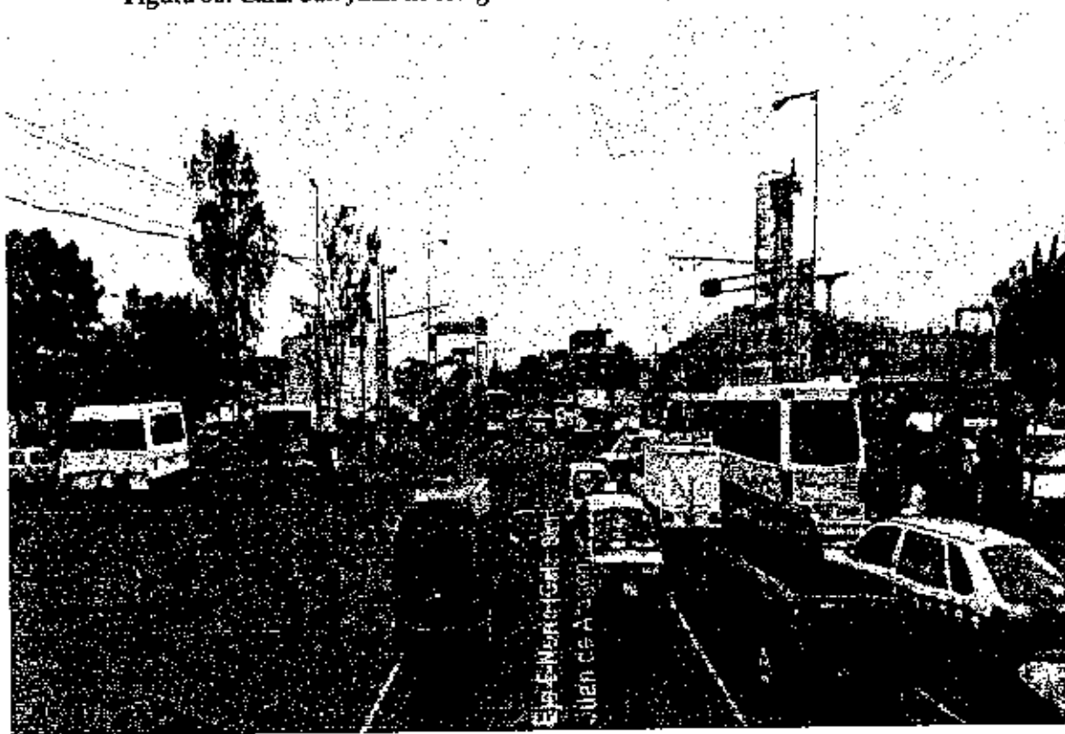
MIA General "Construcción del Corredor Vial para el Transporte Público Línea 6 Metrobús en el Eje 5 Norte de la Avenida Hank González hacia el Metro Rosario con una Influencia en las Delegaciones Gustavo A. Madero y Azcapotzalco"
