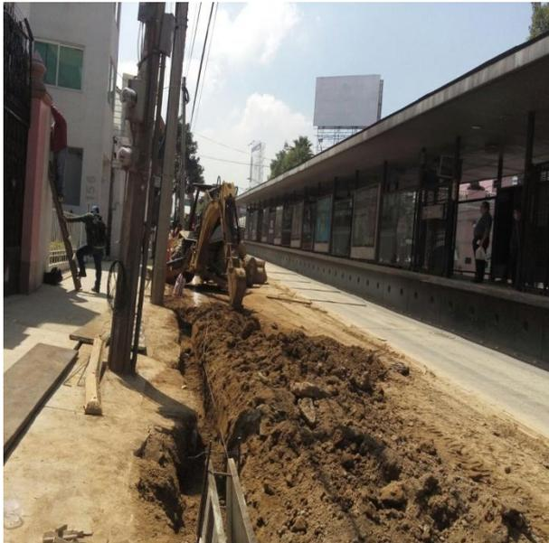
**Trabajos de rehabilitación del drenaje adyacente a la estación Viaducto**
