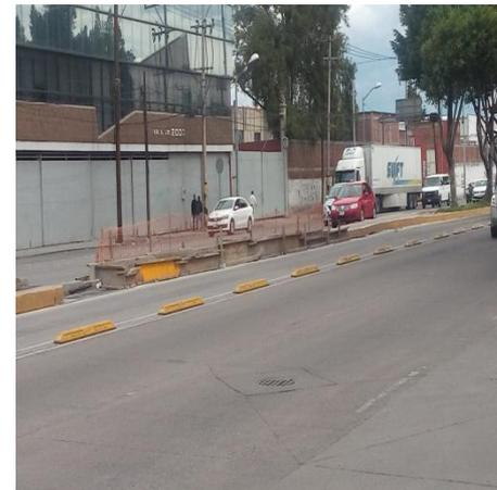
**Reparación de guarniciones y colocación de pintura en el tramo Coltongo a Tenayuca**
