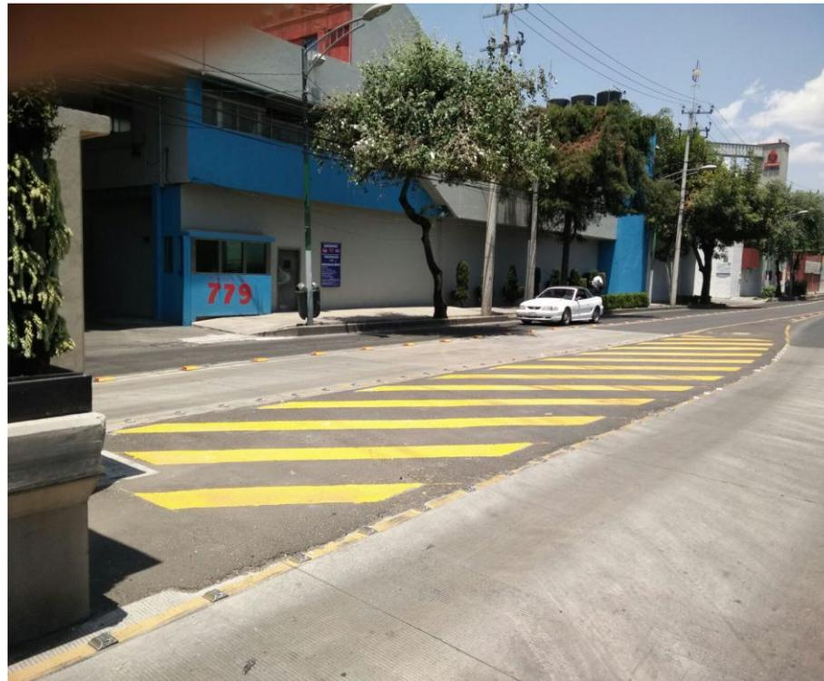
**Balizamiento del Abocinamiento con pintura termoplástica amarillo tránsito a la llegada de las estaciones**
