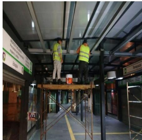
**Sustitución de policarbonato de techumbre y pintura en estructura metálica en la estación Tenayuca**
