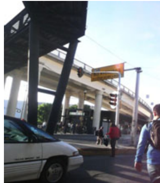
Salida de terminal Tenayuca
