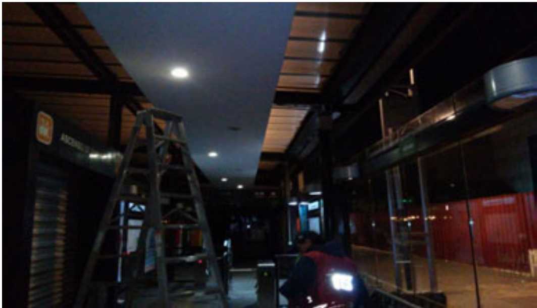
Mantenimiento y limpieza de luminarias de andén
