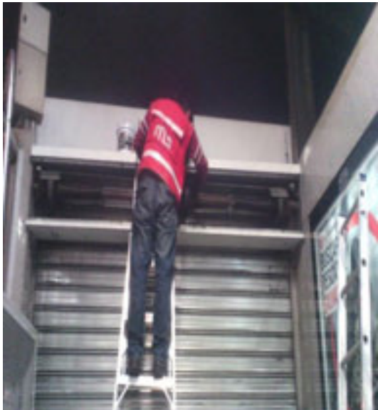
Mantenimiento, reparación y lubricación a cortinas de acceso
