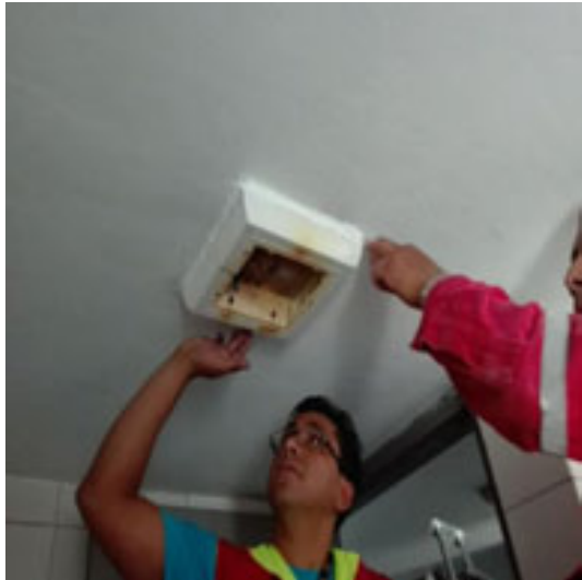
Mantenimiento, limpieza y alineación de luminaras en andén
