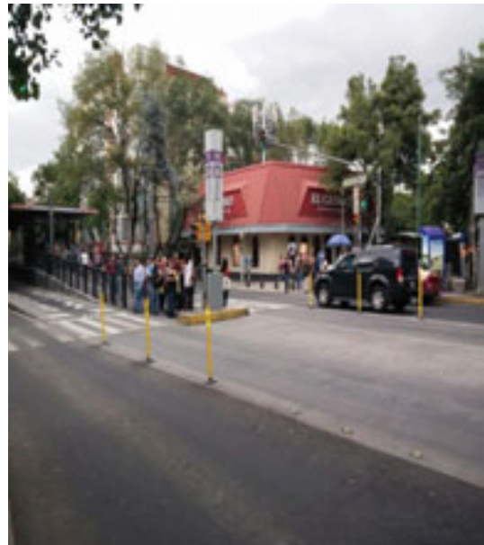
Instalación de ITOS de precaución en carril confinado
